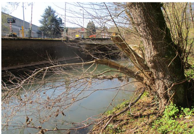
Foto gegen Fließrichtung
