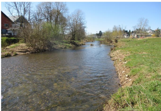
Foto gegen Fließrichtung
