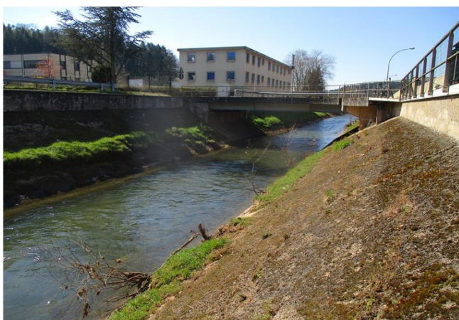
Foto gegen Fließrichtung
