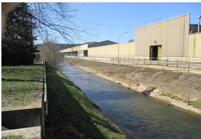
Foto gegen Fließrichtung
