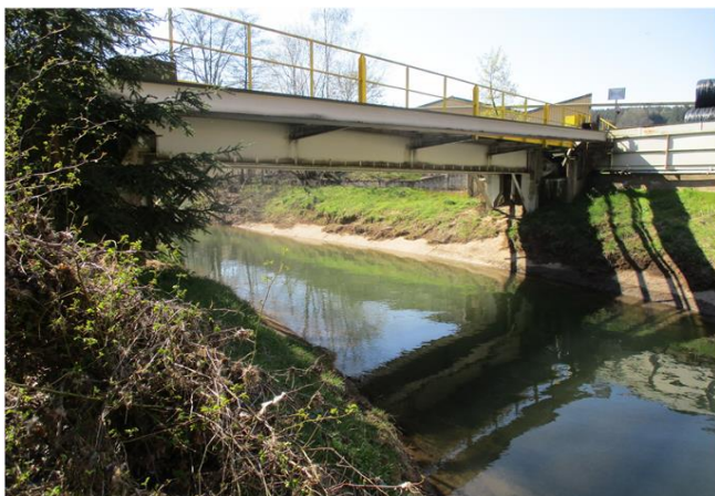
Foto gegen Fließrichtung
