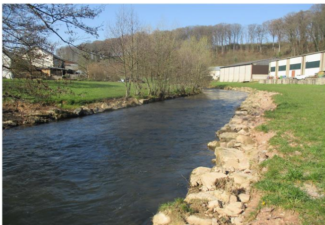
Foto gegen Fließrichtung
