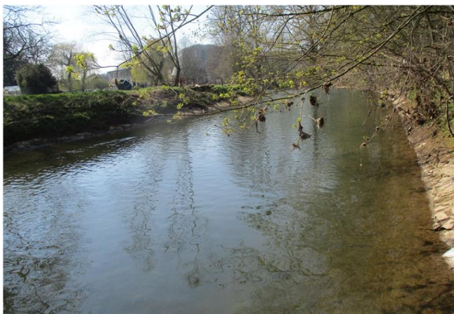
Foto gegen Fließrichtung
