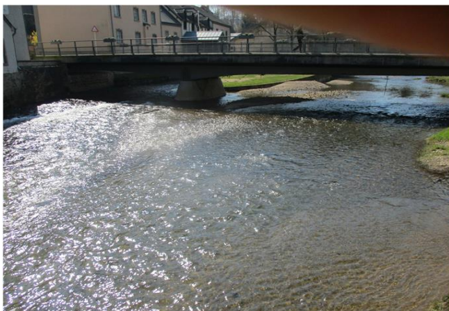
Foto gegen Fließrichtung
