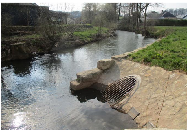
Foto gegen Fließrichtung
