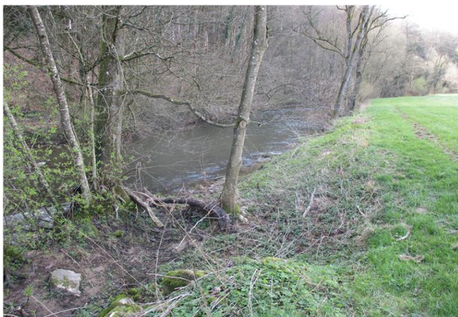
Foto gegen Fließrichtung
