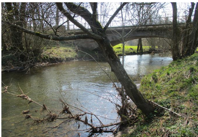
Foto gegen Fließrichtung
