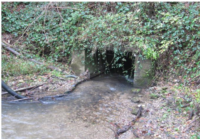
Foto gegen Fließrichtung
