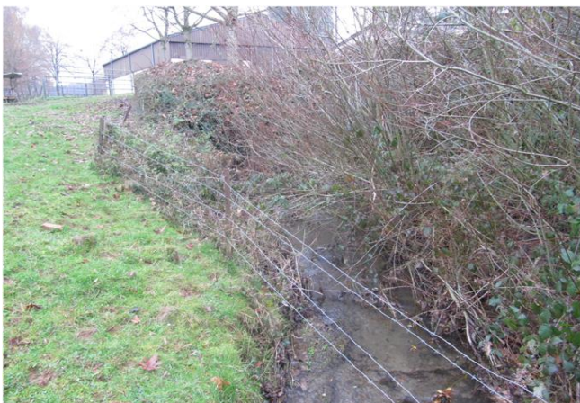
Foto gegen Fließrichtung
