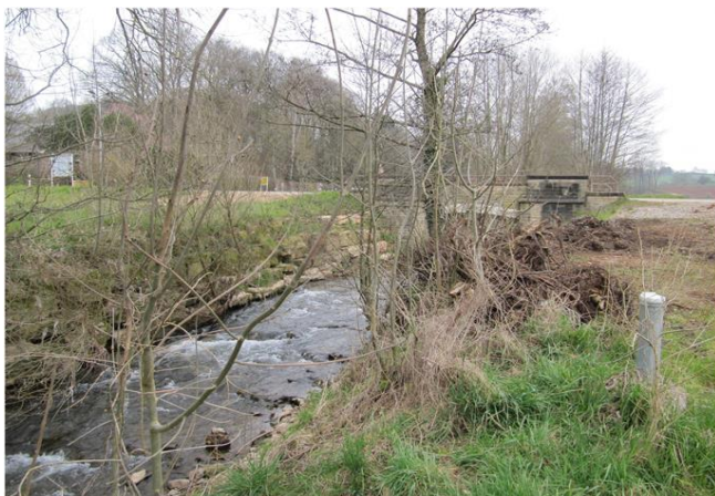
Foto gegen Fließrichtung
