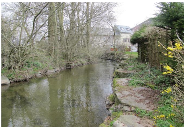
Foto gegen Fließrichtung
