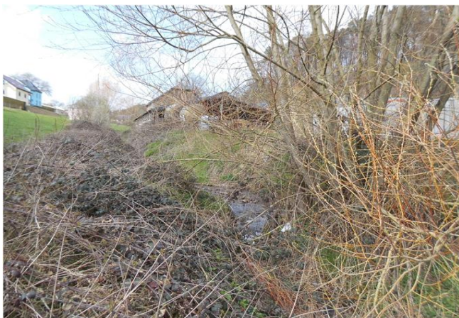
Foto gegen Fließrichtung
