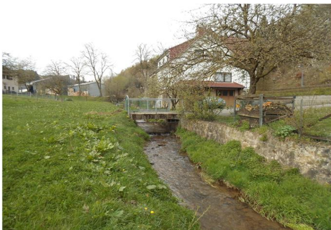
Foto gegen Fließrichtung
