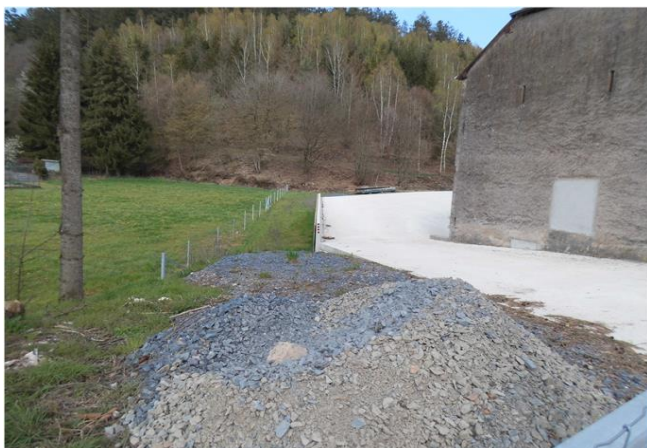
Foto gegen Fließrichtung
