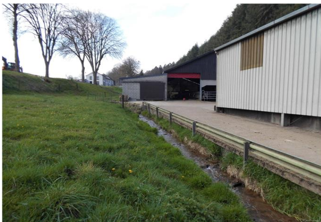
Foto gegen Fließrichtung
