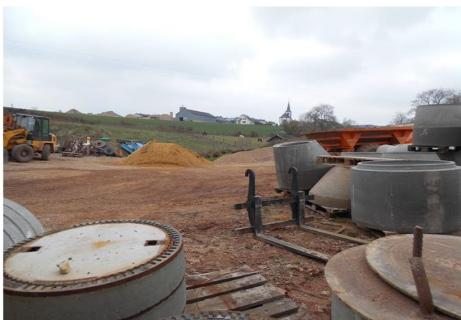
Foto gegen Fließrichtung
