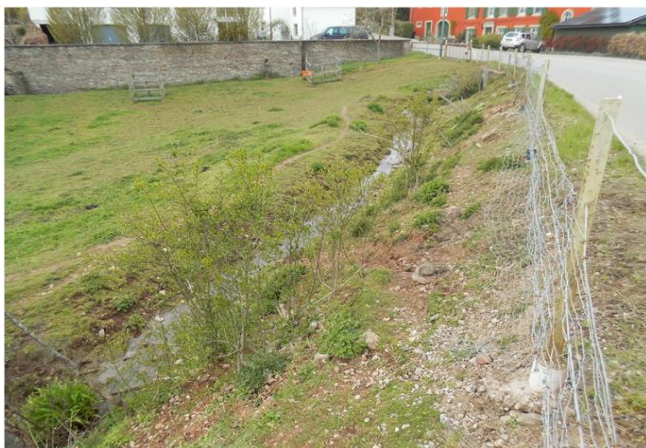
Foto gegen Fließrichtung
