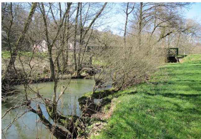
Foto gegen Fließrichtung
