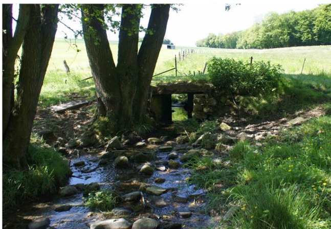
Foto gegen Fließrichtung
