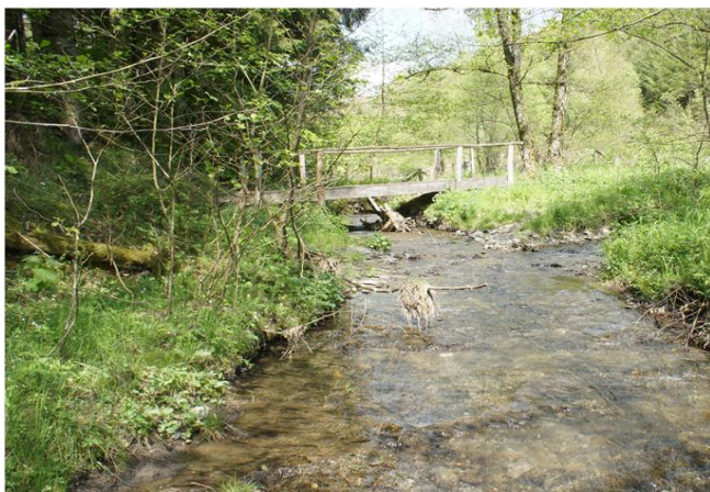
Foto gegen Fließrichtung
