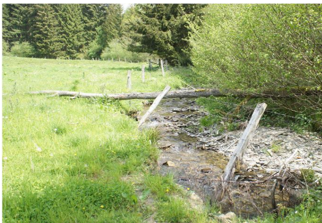
Foto gegen Fließrichtung
