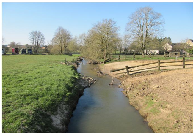
Foto gegen Fließrichtung
