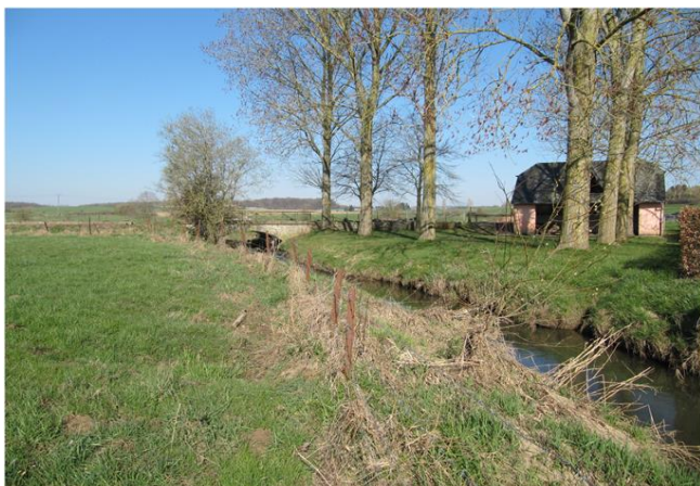
Foto gegen Fließrichtung
