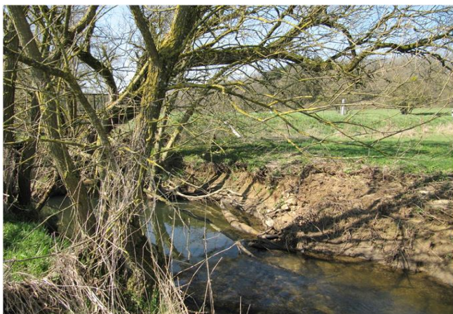
Foto gegen Fließrichtung
