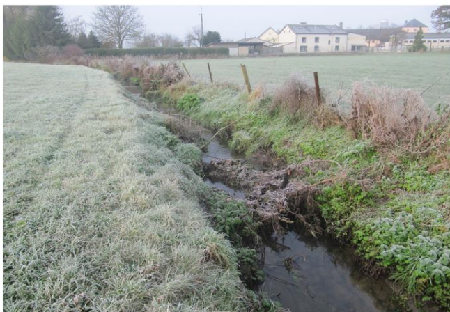
Foto gegen Fließrichtung
