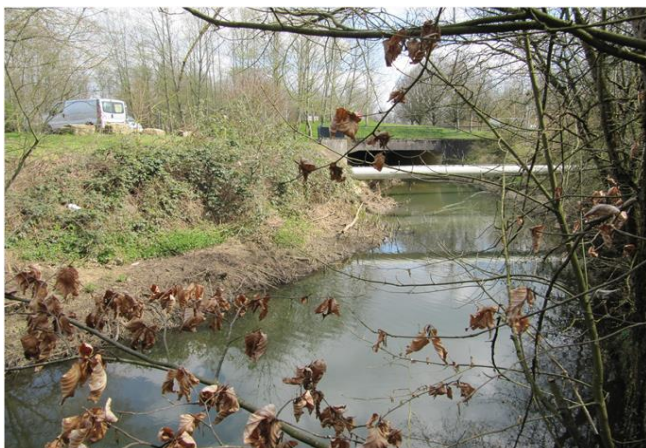
Foto gegen Fließrichtung
