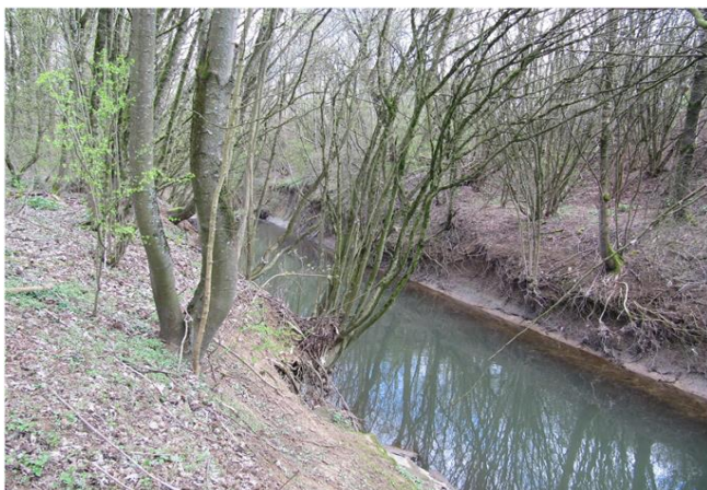
Foto gegen Fließrichtung
