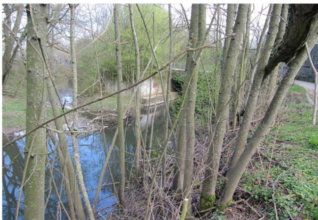
Foto gegen Fließrichtung
