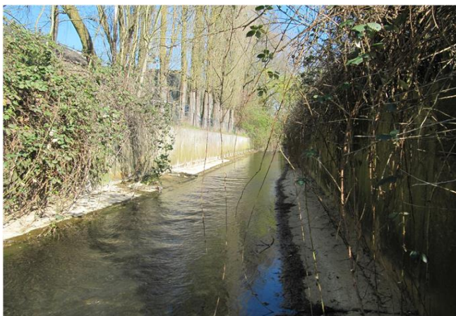
Foto gegen Fließrichtung
