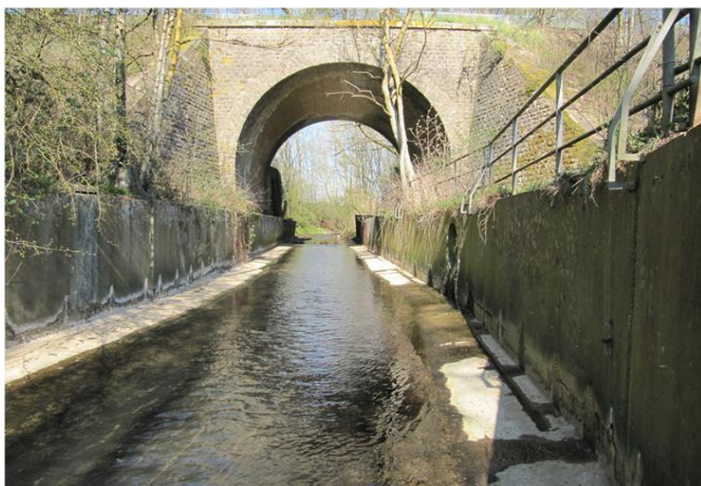
Foto gegen Fließrichtung
