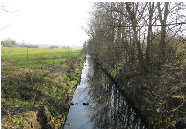
Foto gegen Fließrichtung
