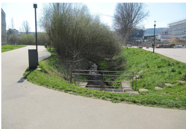
Foto gegen Fließrichtung
