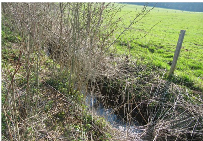
Foto gegen Fließrichtung
