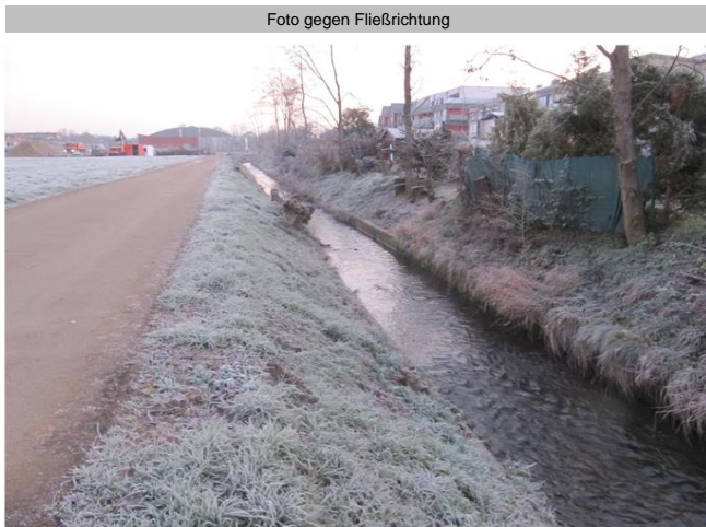
Foto gegen Fließrichtung
