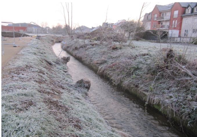
Foto gegen Fließrichtung
