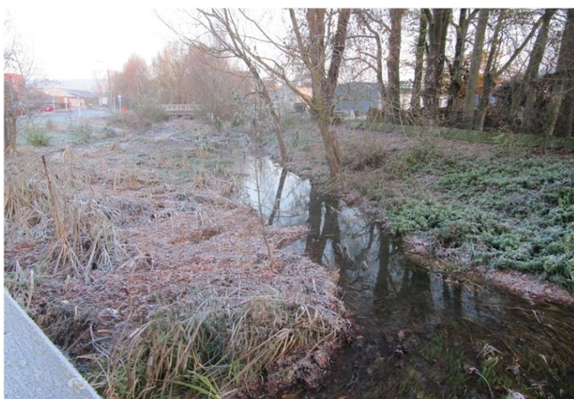
Foto gegen Fließrichtung
