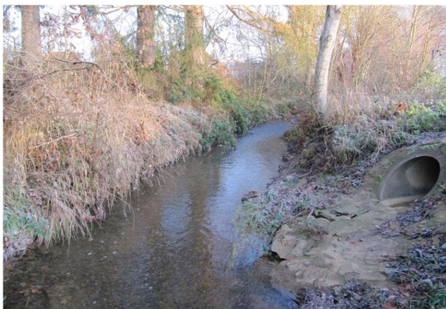
Foto gegen Fließrichtung
