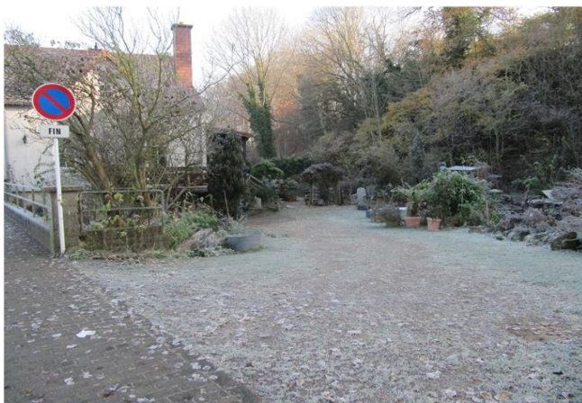
Foto gegen Fließrichtung
