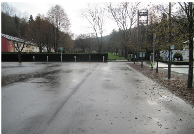
Foto gegen Fließrichtung
