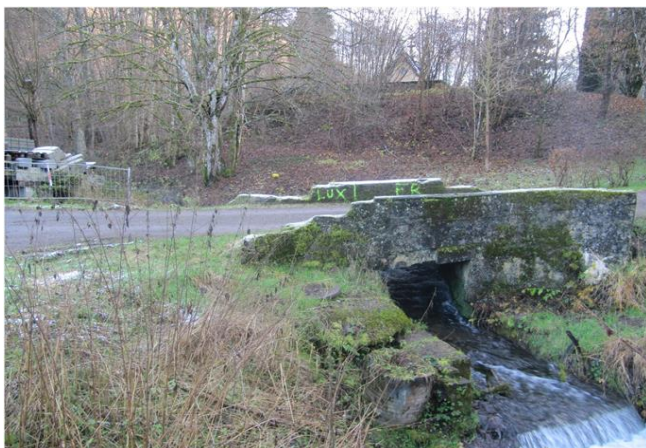
Foto gegen Fließrichtung
