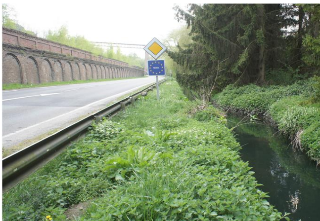
Foto gegen Fließrichtung
