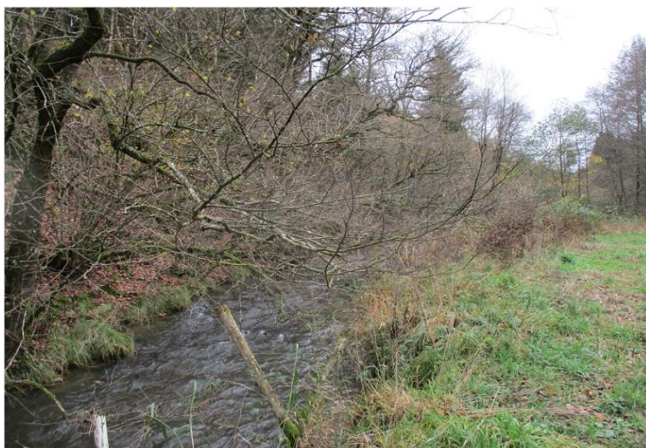
Foto gegen Fließrichtung
