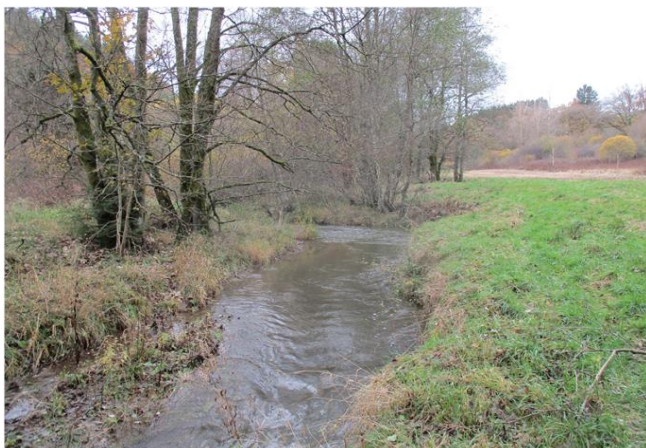
Foto gegen Fließrichtung
