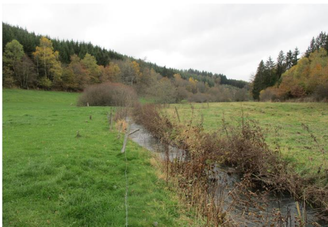
Foto gegen Fließrichtung
