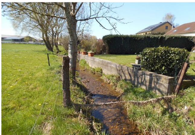
Foto gegen Fließrichtung
