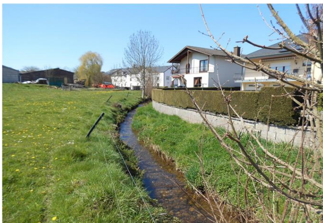
Foto gegen Fließrichtung
